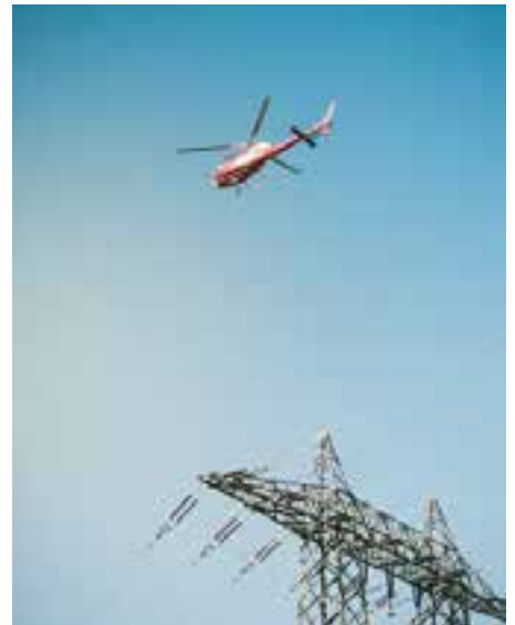
Überprüfung der Stromleitungen via Heli.
